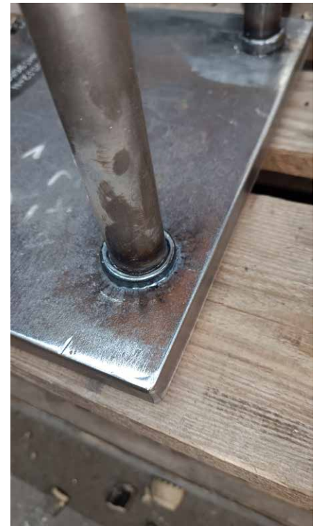
Bild 2: Einwandfreier Schweißwulst, geschweißt mit Keramikring (© Trillmich)
